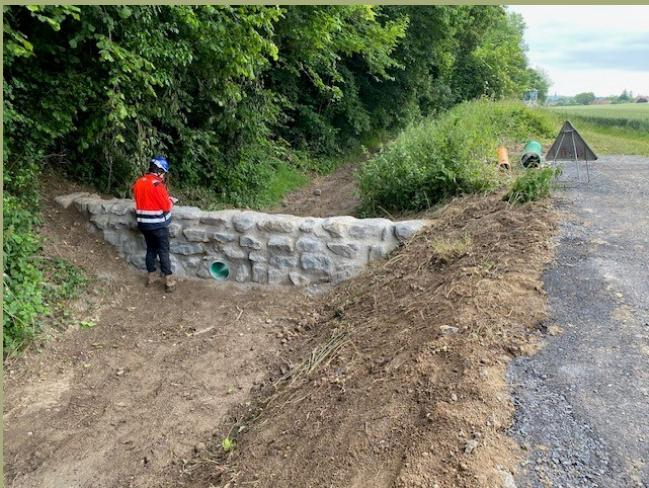
Dans le cadre du programme GEMAPI, encadré par la CALL, des travaux ont été engagés pour la retenue des eaux en cas de forts orages. Un muret de soutènement a été construit, l'aménagement du chemin en cailloux a débuté. La durée prévue des travaux est d'environ un mois. Des travaux d'aménagement du chemin sont en cours.
