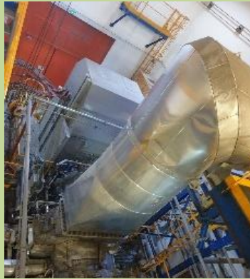
Centre de Valorisation Énergétique – Noyelles- sous-Lens
